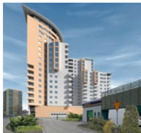
W trakcie realizacji 18-kondygnacyjny wieżowiec Skarbiec Nieruchomości 6 przy ul. Bandurskiego
